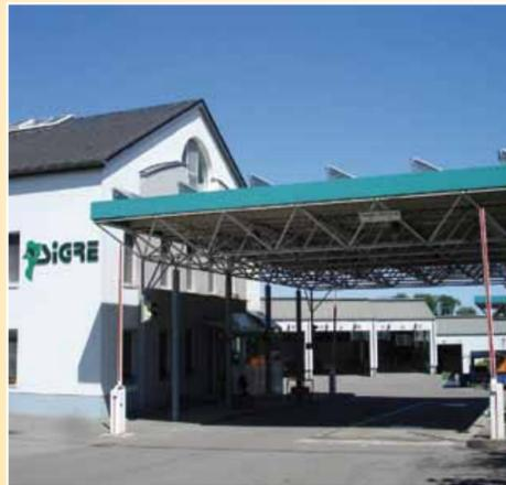
Eine Photovoltaik-Anlage auf der Waagen-Überdachung liefert auch hier umweltfreundlichen Strom; sie wurde mit dem Prix Nova Naturstrom 2011 ausgezeichnet. Zusammen mit der Deponiegas-Verstromung wird am Standort Muertendall also mittlerweile mehr Strom produziert wie selbst verbraucht.
